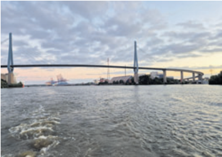
Im September muss die Köhlbrandbrücke gleich an zwei Wochenenden voll gesperrt werden Foto: au
