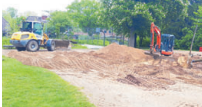
Mit schwerem Gerät wurde altes Erdreich abgetragen Foto: W. Marsand
