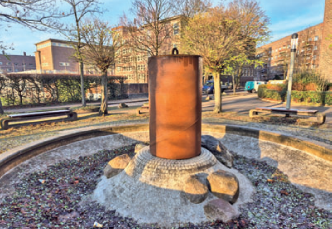
Der Brunnen auf der Veddel wird seit Kurzem durch eine speziell angefertigte Stahlröhre vor Vandalismus geschützt Foto: au
