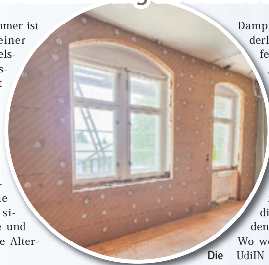
Die Montage erfolgt ohne Kleber mit einem patentierten Dübelsystem Foto: UdiDämmsysteme
