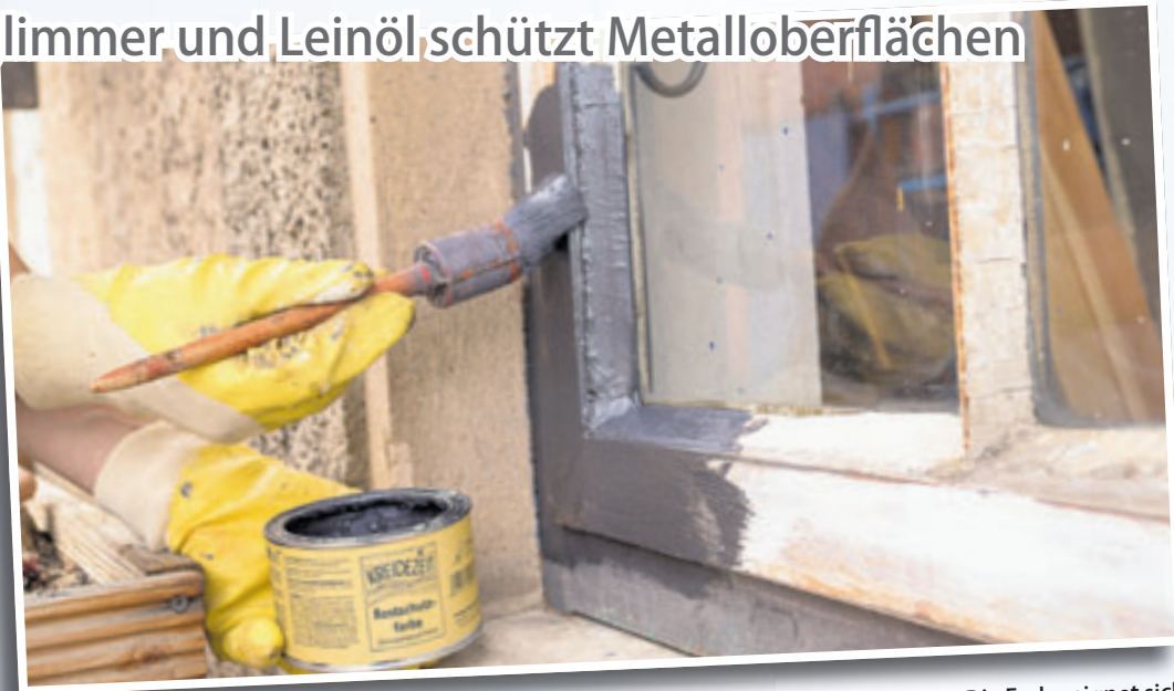
Es reicht, die Metallteile vor dem Anstrich per Drahtbürste oder Schleifpapier zu entrostern. Die Farbe eignet sich auch als dekorativer Anstrich für Holzoberflächen
