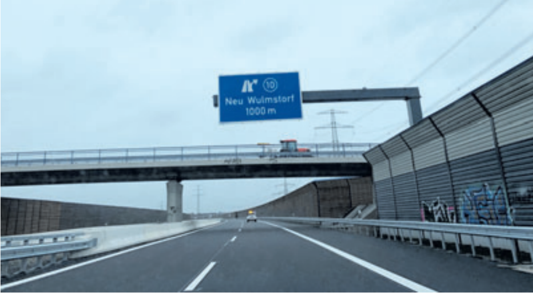
Mitte Oktober 2025 sind die Arbeiten für die Sanierung des Damms südlich des Brückenbauwerks 8101 im Bereich der Anschlussstelle (AS) Neu Wulmstorf der A26 gestartet Foto: Autobahn GmbH
