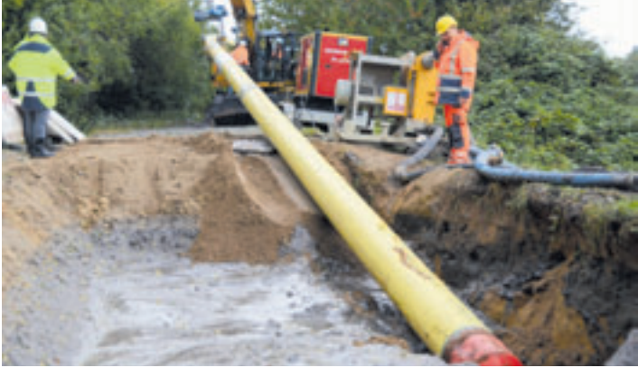
Kombinierter Leitungsbau für die Energiewende: Ein 270 Meter langes Stahlrohr unterquert nun das Gewässer Aue zwischen Moorburg und Finkenwerder. Es enthält sowohl eine Wasserstoffleitung des Projekts HH-WIN als auch Stromleitungen, um den steigenden Energiebedarf auf der Elbinsel abzudecken Foto: Hamburger Energienetze
