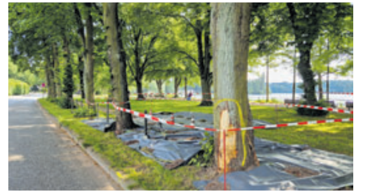
Nur wenige Stunden nach dem schweren Unfall an der Außenmühle ist nur noch ein beschädigter Baum, Abdeckplanen und Flatterband an der Unfallstelle zu sehen
