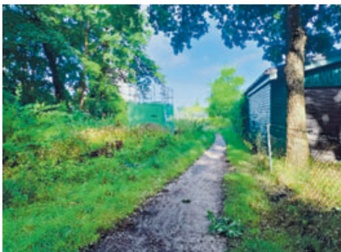
Der Verbindungsweg befindet sich in einem schlechten Zustand Foto: CDU
