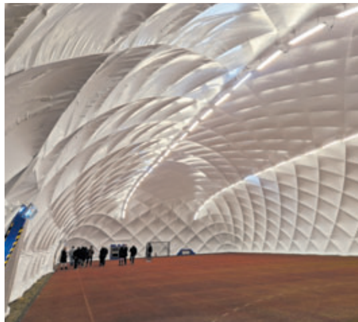
Seit März ermöglicht die mobile Tragluft-halle wieder Sport in Finkenwerder. Um das Glück perfekt zu machen, soll nun auch noch ein geeigneter Hallenboden verlegt werden Foto: au
