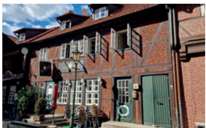
Von außen ist vom Brand nicht mehr viel zu sehen, im Inneren laufen die Aufräumarbeiten auf Hochtouren
