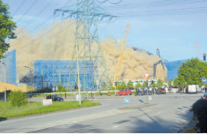
Staubentwicklungen traten beim Abriss des Kohlekraftwerkes Moorburg unter anderem im unmittelbaren Arbeitsbereich bei den Abbrucharbeiten am Hybridkühlturm und den Aschesilos auf
