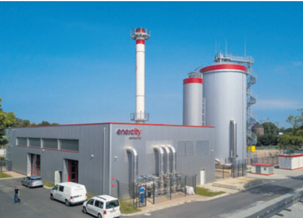
Die Energiezentrale Peute verteilt die Industriewärme auch auf benachbarte Stadtteile Foto: energycity contracting/Bodo Dretzke
