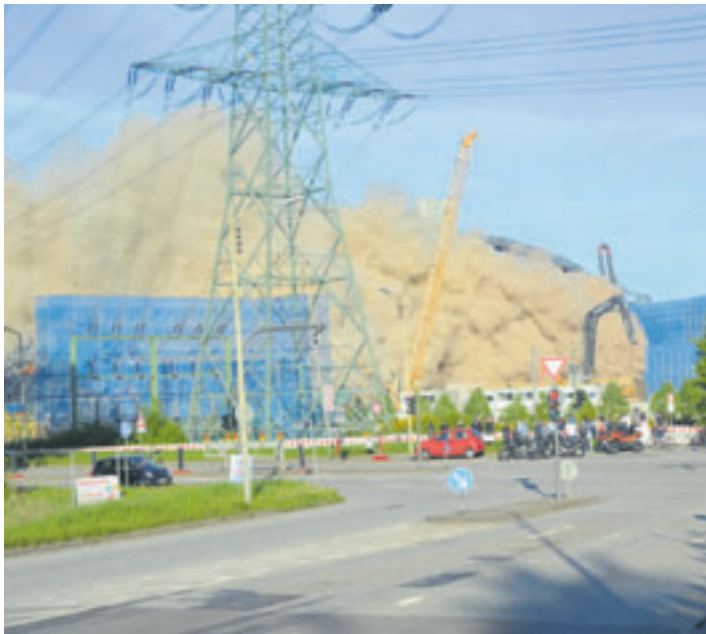
Staubentwicklungen traten beim Abriss des Kohlekraftwerkes Moorburg unter anderem im unmittelbaren Arbeitsbereich bei den Abbrucharbeiten am Hybridkühlturm und den Aschesilos auf
