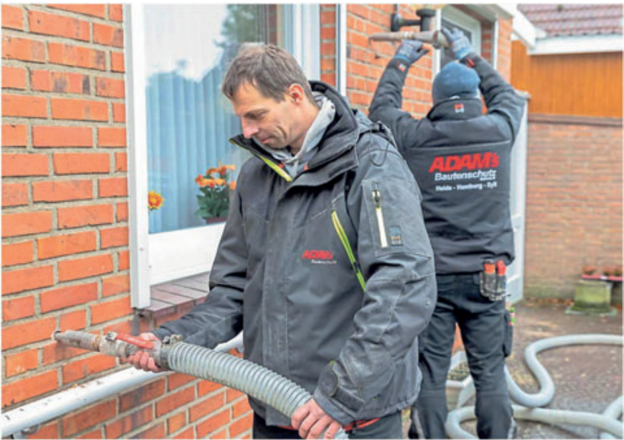
Die Mitarbeiter von Adam's Bautenschutz blasen durch vorher gebohrte Löcher die Steinwolle von Rockwool in die Luftschicht ein. Die Löcher werden nach der Dämmung fast unsichtbar durch die Bautenschutzfachleute wieder verschlossen. Fotos: Turchetto
