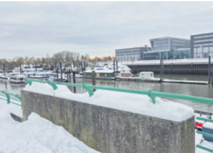
Der Steendiekkanal vergangenen Woche im Winterschlaf: Am westlichen Ufer wird nun ein neuen Radweg zwischen dem Fähranleger Rüschnpark und dem Hein-Saß-Weg gebaut
