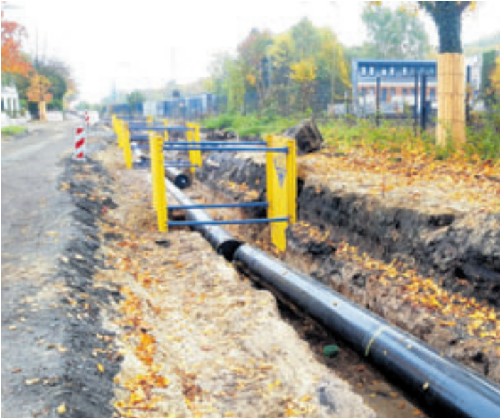
Im Zuge des Ausbaus der Radroute 10 (Radschnellroute) wurden im Bereich Am Radeland West, ab Hausnummer 84 bis zur Einmündung des Bostelbeker Damms sowie am Tempowerkring die Vorfahrtsverhältnisse auf „Rechts vor Links“ umgestellt Foto: W. Marsand
