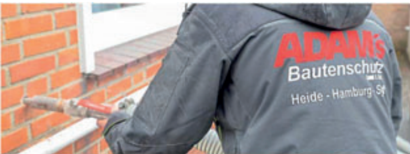
Die Löcher für die Einblasdämmung werden in einem bestimmten Muster gebohrt. So wird gewährleistet, dass die Luftschicht des Mauerwerks auch lückenlos befüllt wird.
