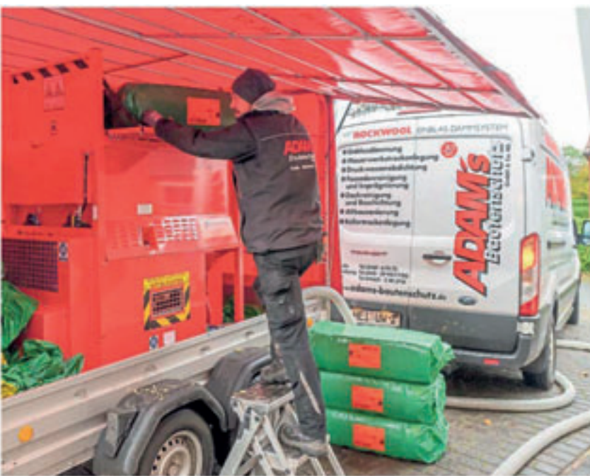
Pascal Machholz, Mitarbeiter bei Adam's Bautenschutz, füllt die Steinwolle von Rockwool in die Rockwool-Einblas-Maschine, die über dicke Schläuche das Dämmmaterial direkt in die Luftschicht des Mauerwerks transportiert.
