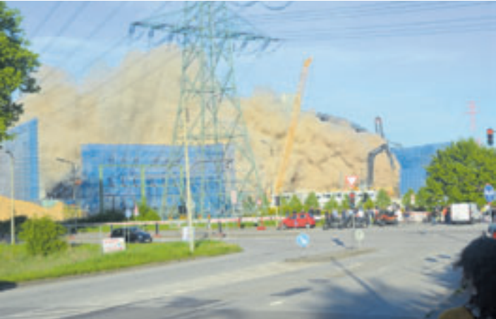
Staubeentwicklungen traten beim Abriss des Kohlekraftwerkes Moorburg unter anderem im unmittelbaren Arbeitsbereich bei den Abbrucharbeiten am Hybridkühlturm und den Aschesilos auf
