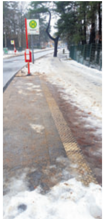
Zweierlei Maß: Zwar ist der Wartebereich der Bushaltestelle Bergheide in Neugraben von Eis und Schnee befreit, für den Geh- und Radweg gilt dies aber nicht Foto: W. Marsand
