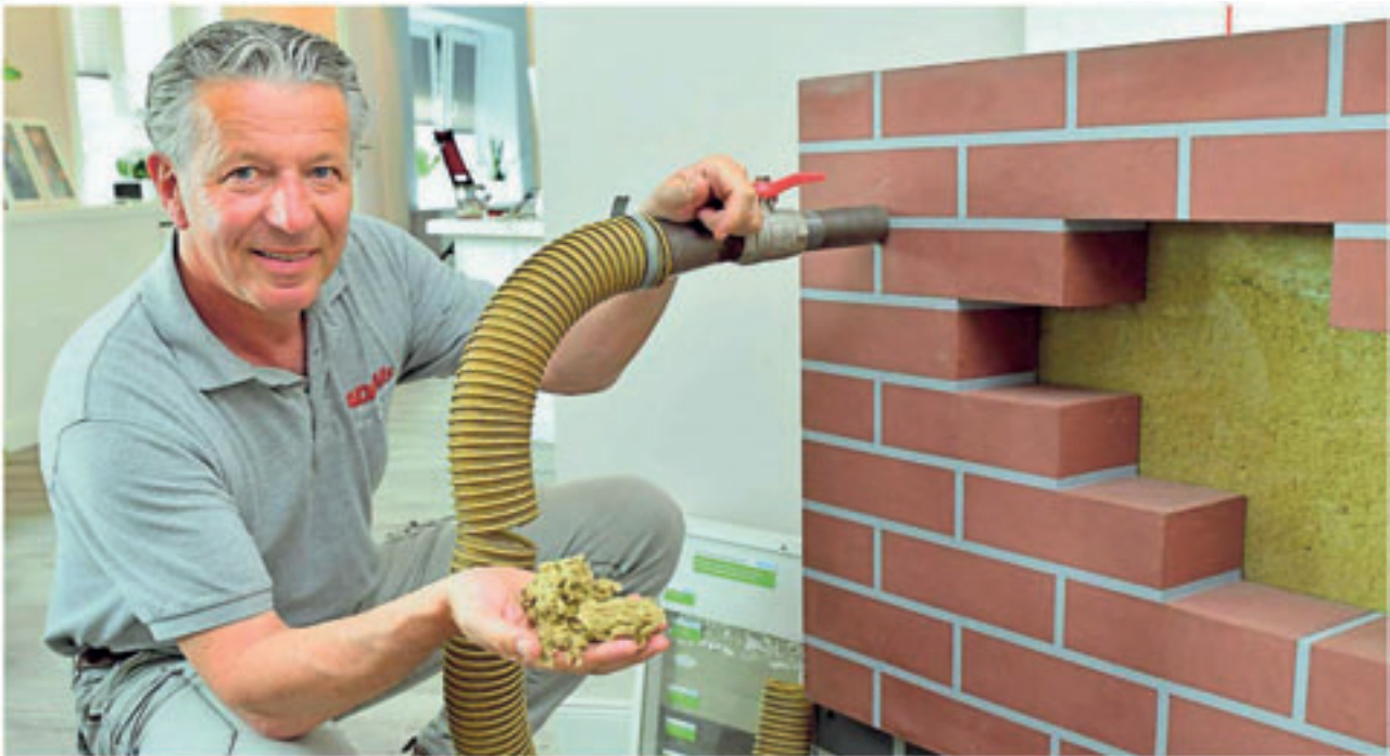
Bautenschutzfachmann Kai Adam empfiehlt Rockwool Steinwolle für eine nachträgliche Kerndämmung.
