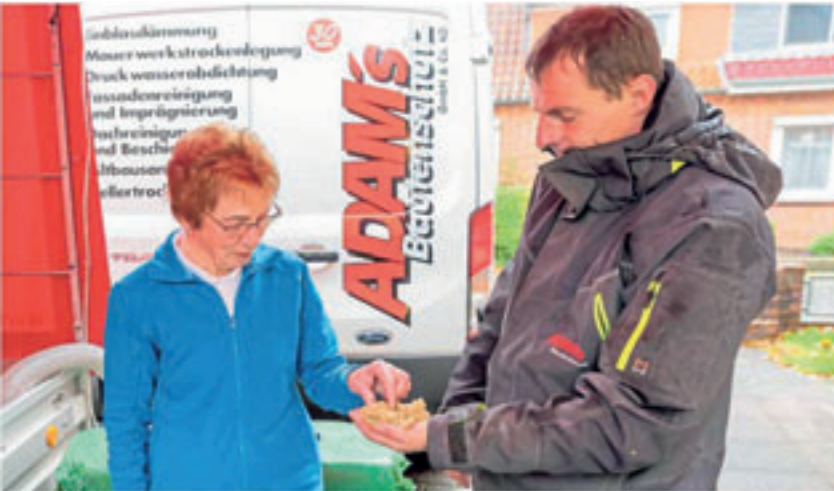
Angela Mälzer aus Heide hat sich für eine Dämmung ihres Hauses mit Steinwolle von Rockwool entschieden. Hier zeigt Dirk Idem, Mitarbeiter von Adam's Bautenschutz, das hervorragende Dämmmaterial, das die Luftschicht im Mauerwerk lückenlos ausfüllt. So wird eine sofortige Dämmwirkung in nicht mal einem Tag erzielt.
