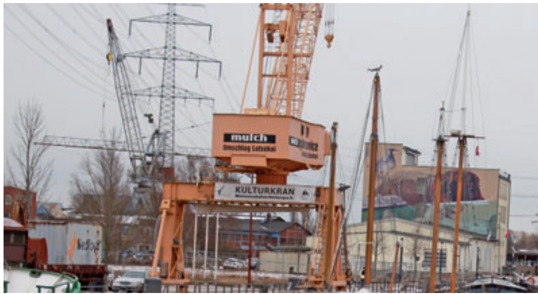
Vom 23. bis 24. September 2023 wird die Industriekultur am Wasser wie der Mulch-Kran im Harburger Binnenhafen in der Metropolregion Hamburg wieder live erlebbar sein. Foto: ein
