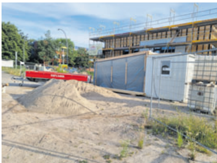
Eigentlich sollten das Funktionsgebäude (hinten im Bild) und gleich daneben die geplante Kaltfluthalle bereits so gut wie fertig sein. Der Bau der Kaltfluthalle wurde vorläufig ausgesetzt Foto: au
