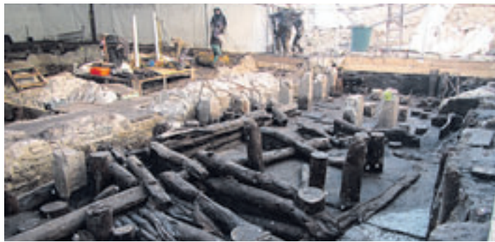
Der Sensationsfund: Reste der im 11. Jahrhundert errichteten Ringwallbefestigung „Neue Burg“ Foto: ein
