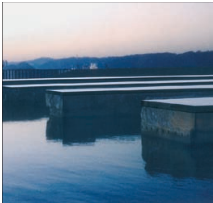
Der Entwurf der Architektinnen Beate Kirsch und Anja Bremer sieht die Umgestaltung der 5 U-Boot-Boxen zu riesigen Sarkophagen vor. Foto: Koltermann
